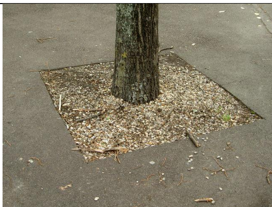
Pied d'arbre bétonné
